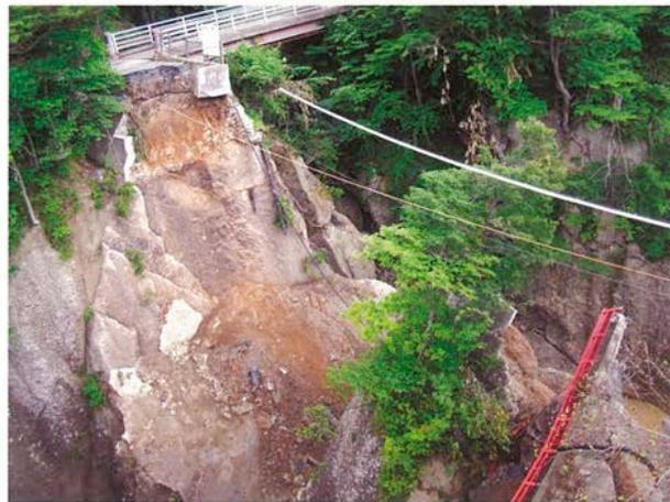
写真-9 橋台を支える岩盤が崩落したため落橋したと見られる旧昇仙橋（歩道橋）。写真右下に赤い落橋した桁が見える。左上には、橋台があった。
