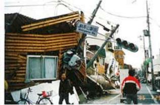
写真-8 これも「震災の帯」[震度7]地域での被害家屋であるが、地震によって、火災延焼防止のためのモルタル吹き付けが、殆どは壊れる場合もあることがわかった。
