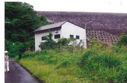
写真-5 正面の荒砥沢ロックフィルダムは何の被害もなく、正面の家屋も無被害であった。
