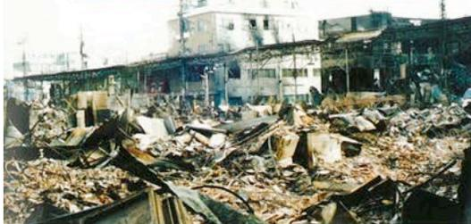
写真-13 「震災の帯」地区のように倒壊家屋が多いと、火元も多く発生するし、家の下敷きになる人も多く、その救出が第一となって、初期消火ができず、消防自動車も障害物などのため駆けつけられず、また消火用水も不足して、大火となることが多い。(神戸市長田区)
