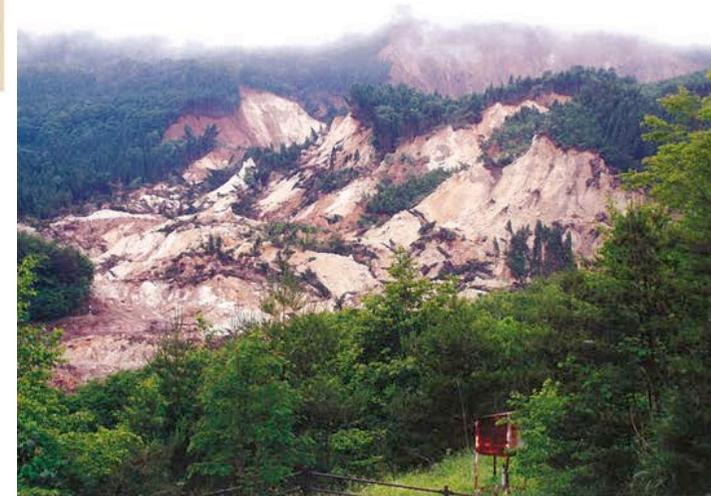
写真-3 荒砥沢ダム(ロックフィル、堤高74.4m、農業用水)のダム反対側の山が大規模崩壊を起した。その規模は延長約1.3km、最大幅約900m、最大厚さ150mで、何回もの進行性破壊であったとされている。
