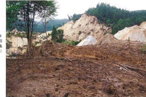
写真-4 山腹崩壊そばの周囲道路(手前)も、亀裂が入り、崩壊土に埋まっている。
