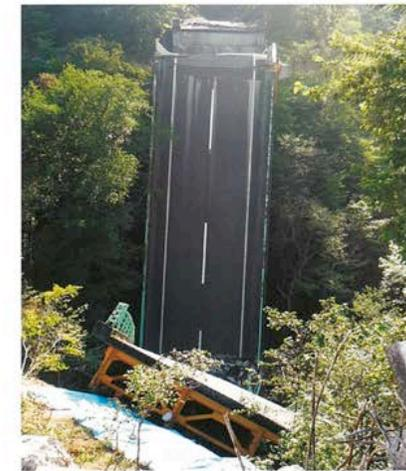
写真-10 橋台地盤が崩壊したためと思われる祭時「まつるべ」大橋の破壊状況。（鈴木崇伸東洋大学教授提供）
